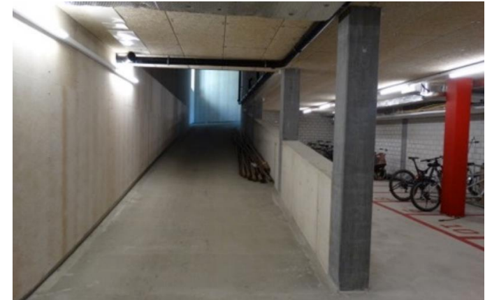
Beispiel Rampenneigung 6% Foto: giesserei Winthertur
