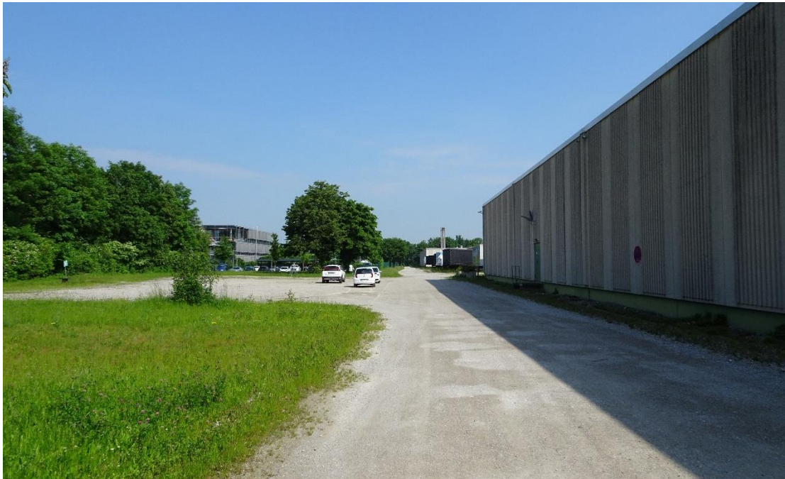
Abb. 5: Blick in Richtung Norden entlang der westlichen Seite der Lagerhalle (FI.Nr. 198)
